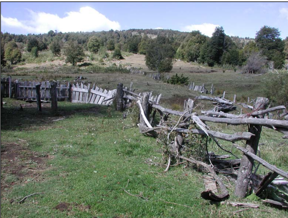
Fotografía 12. Cerco de madera en estado muy pobre, sin funcionalidad
