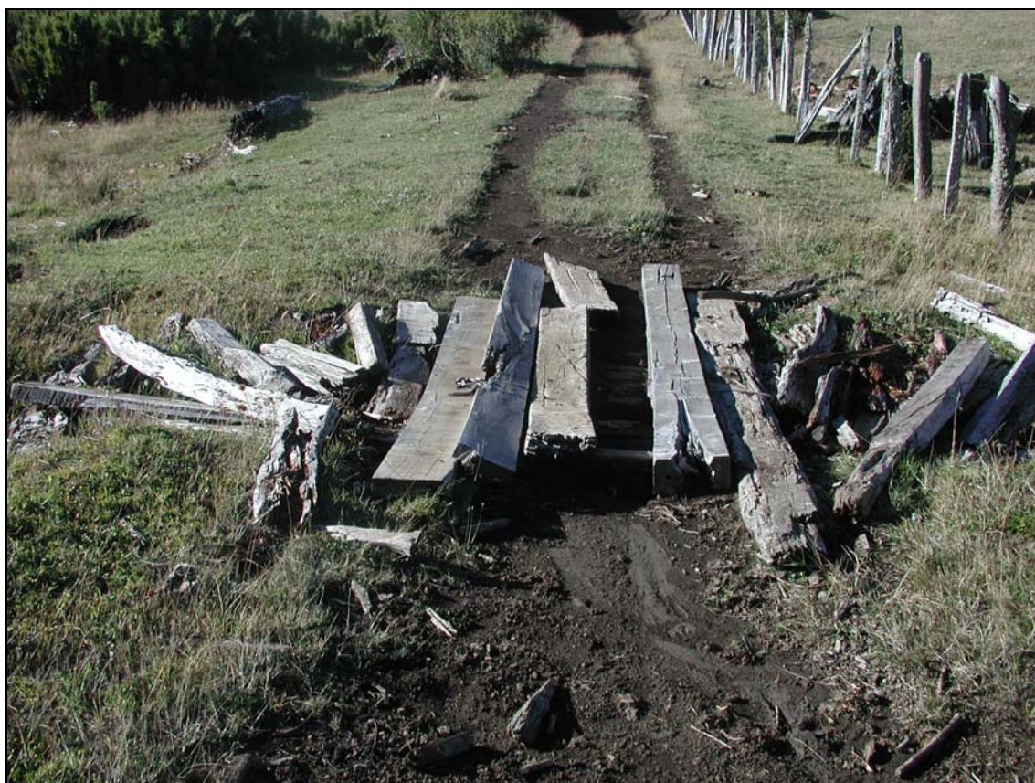
Fotografía 13. Aspecto de un camino predial con traviesas de madera
