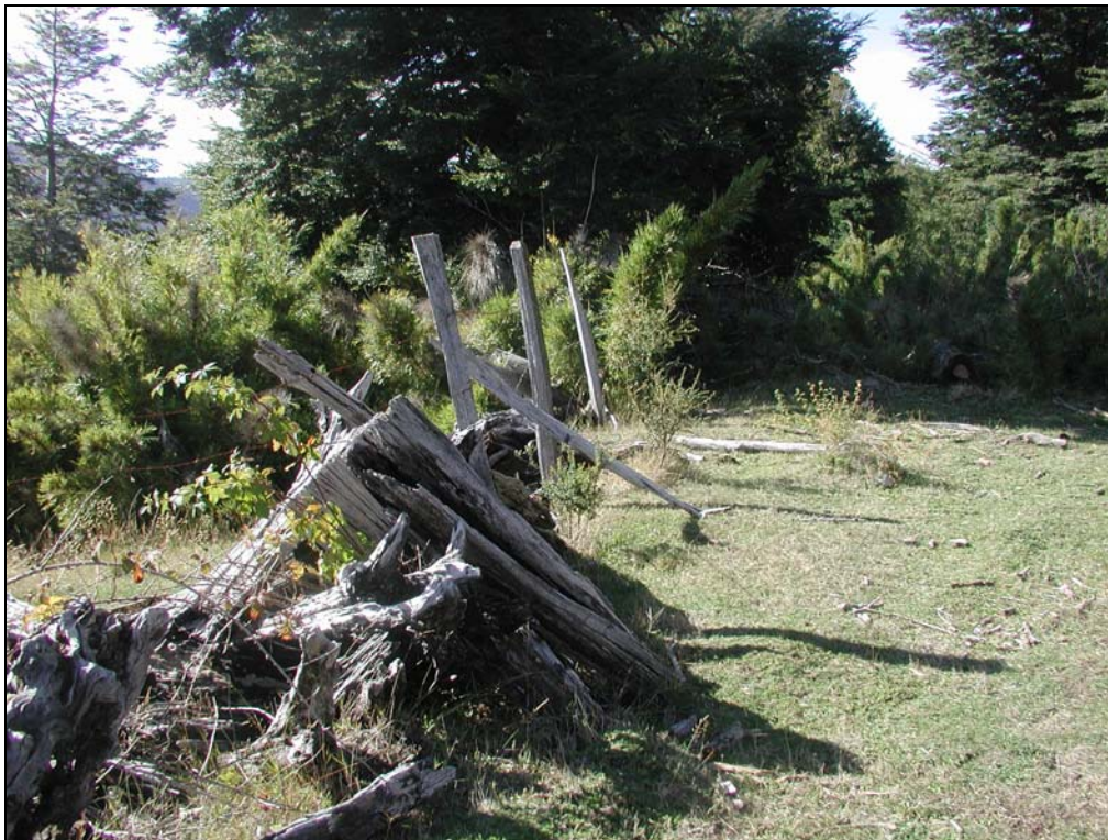
Fotografía 10. Estado de deterioro de un cerco de alambre de púas
