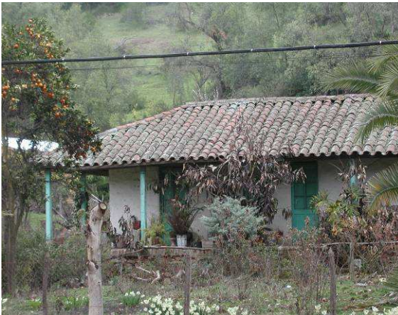
Figura 58. Vivienda de inquilino, construida en la época hacendal.
