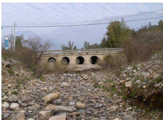
Figura 34. Puente estero Las Cabras, camino ripio, Rangue.
