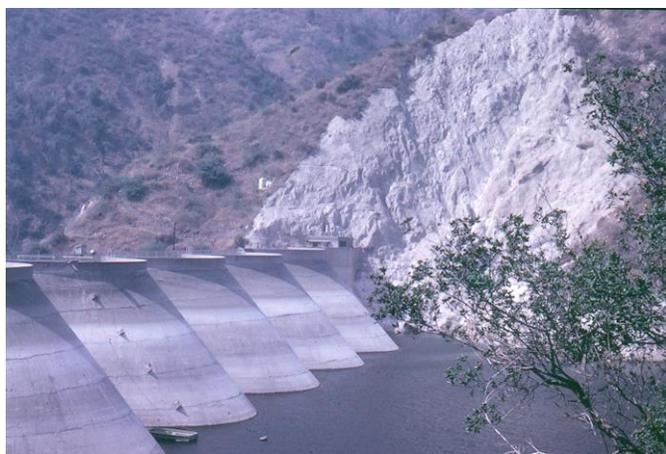
Foto 107. Represa reguladora de crecidas irruptivas, como estructura de protección de inundaciones en el valle de San Dimas, EEUU (Año 1967)
