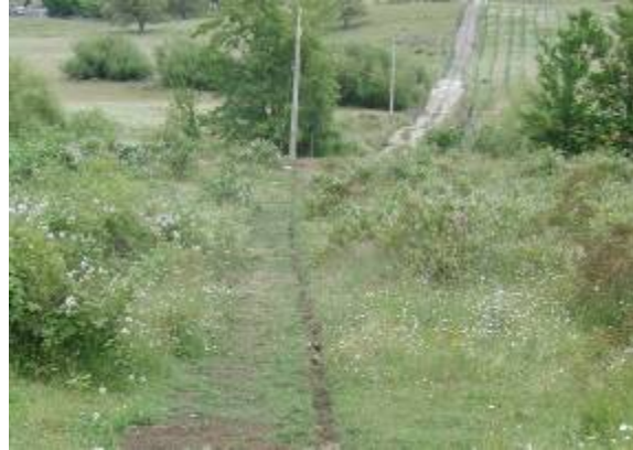
Foto 58. Red eléctrica con sectores superficiales y subterráneos.
