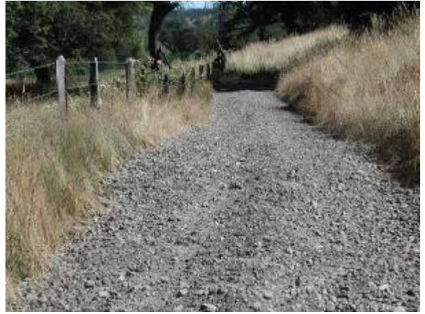
Foto 52. Camino estabilizado con ripio
