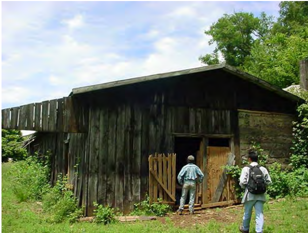
Fig. 31 . Galpón de estructura recuperable, Choin Lafquenche.
