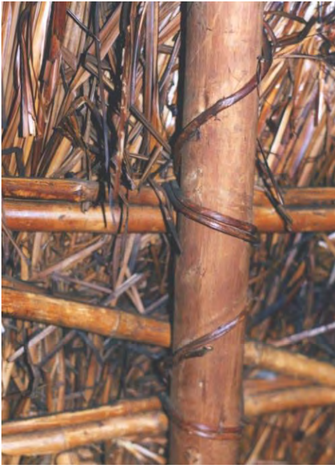
Fig. 20 . Detalle sistema constructivo de la ruka.
