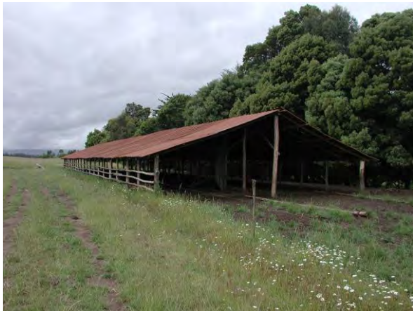
Figura 13 : Bodega demostrativa de la vocación ganadera de este predio.
