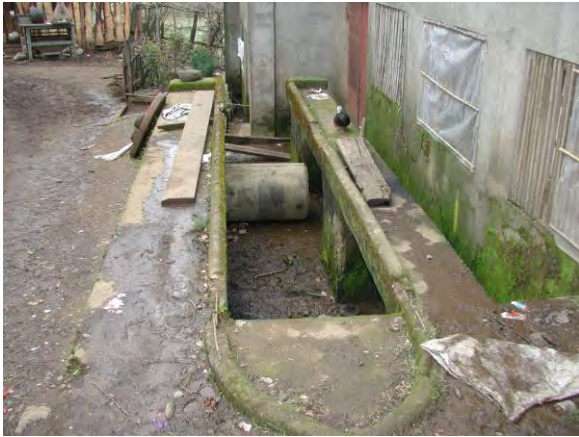
Pozo para reparación de vehículos (tecnestructura)
