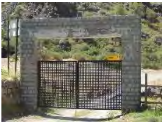
Fotografía7 Zona de ingreso a Cruz de Piedra
